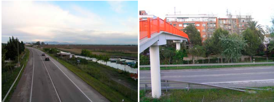
Figure 35, 36. A sinistra, la CV 500 che separa l'abitato di El Saler dal suo porto (visibile sulla destra della foto); a destra la passerella pedonale sopraelevata che collega El Saler al porto.
