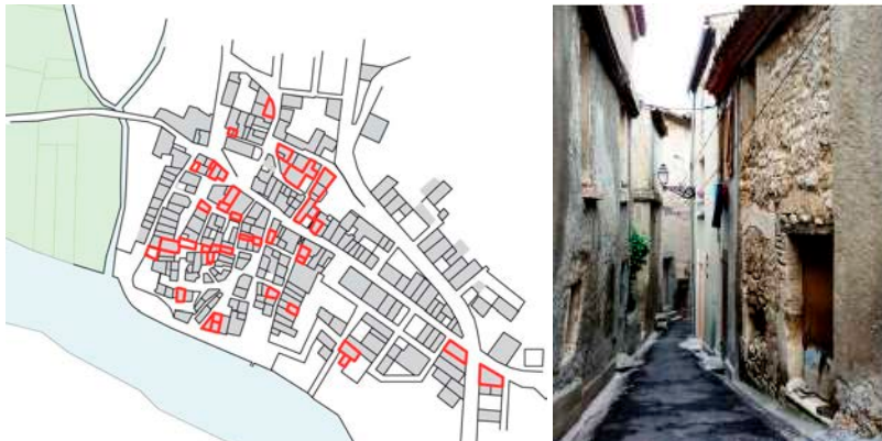
Figure 46, 47. A sinistra, evidenziati gli edifici abbandonati nel centro storico di Portel-des-Corbières, a destra, le condizioni di degrado in cui versano molti di essi. Fonte: PNRNM, École d'architecture de la ville et des territoires, Marne-la-Vallée 2009, pp. 94 e 96.
