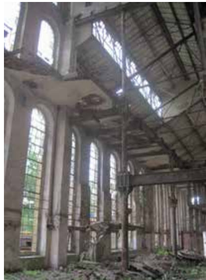
Fig. 6. Vista dello stato attuale della struttura in ghisa e dei pilastri calastrellati (in parte non collegati al terreno)
