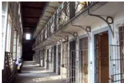
Fig. 8. Vista delle celle, 2012
