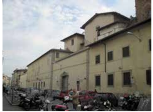
Fig. 2. Prospetto Via della Mattonaia, 2012
