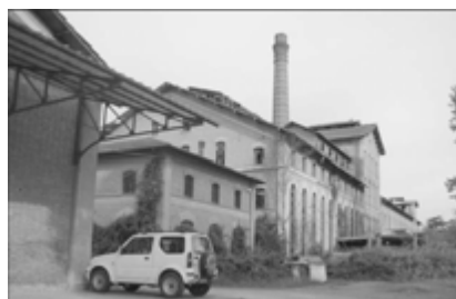
Fig. 10. Immagine attuale (2012). Vista dello zuccherificio lato sud-est
