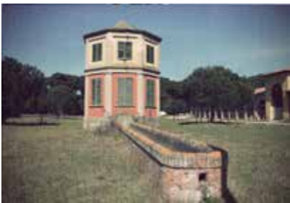
Fig. 7. Foto del manufatto allo stato di fatto: la palazzina, pozzo abbeveratoio
