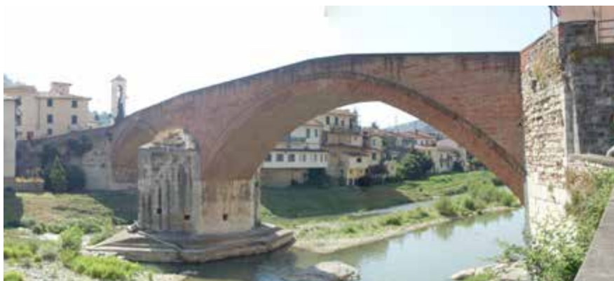
Fig. 2. Foto del Ponte Mediceo sulla Sieve (lato monte)
