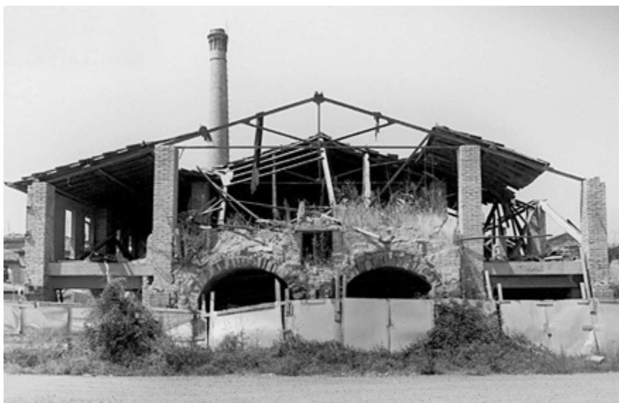
Fig. 2. Sezione aperta dei forni a seguito dell'intervento di demolizione del 2000. In "Fornaci in Umbria. Un itinerario di archeologia industriale", Catalogo regionale dei beni culturali dell'Umbria, Mondadori Electa, 2002, p. 276-277
