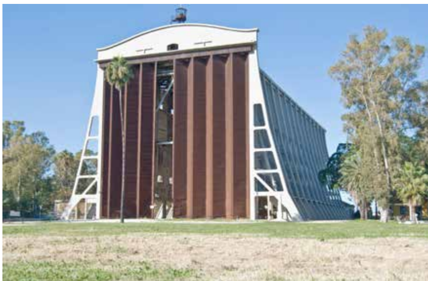
Fig. 1. Vista da sud-est verso il portale metallico di ingresso all'hangar per dirigibili. (novembre 2011)
