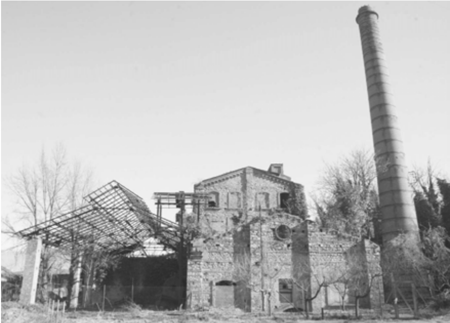
Fig. 1. Ripresa fotografica esterna dello stato di fatto del manufatto (febbraio 2010)
