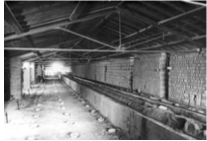
Fig. 4. La zona di alimentazione dei forni, le bocchette di alimentazione del forno. Archivio Storico del Centro Fotografico Tifernate, fondo Gian Luigi Massetti.
