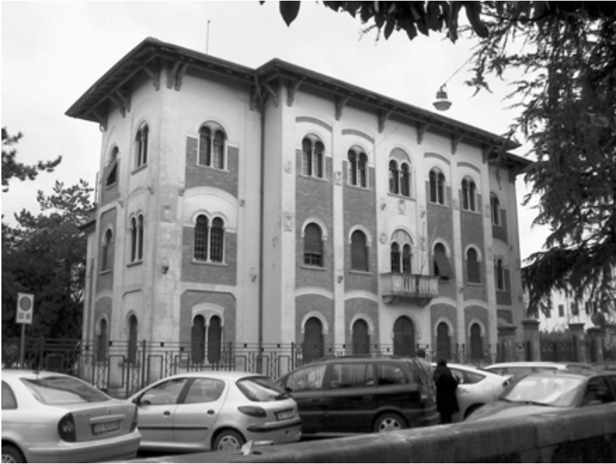
Fig. 7. Edificio del Consorzio Canale Lunense, anno 2006
