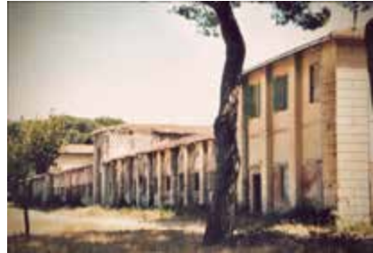
Fig. 6. Foto del manufatto allo stato di fatto: la palazzina, fronte ovest
