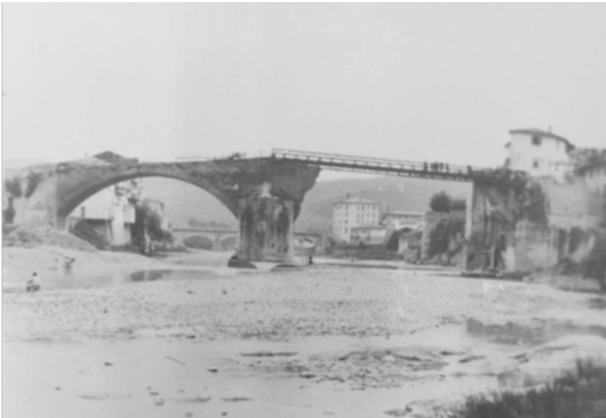
Fig. 5. Foto storica del ponte con l'arcata minata mancante sostituita da una trave metallica, Fototeca Comunale di Pontassieve 1945 ca
