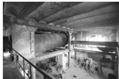
Fig. 6. Ripresa fotografica interna, piano secondo, locale essiccatori (febbraio 2010)
