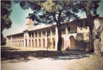
Fig. 5. Foto del manufatto allo stato di fatto: la palazzina, fronte principale
