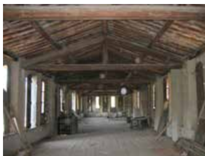
Fig. 2. Vista interna del secondo piano della cartiera, si può distinguere la copertura con capriate lignee
