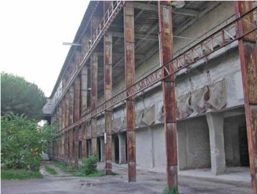
Fig. 2. Vista di dettaglio del silos (2007)
