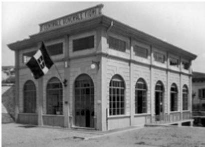
Fig. 11. Foto della Centrale Generale Fiori, anno 1930, Archivio Consorzio Canale Lunense
