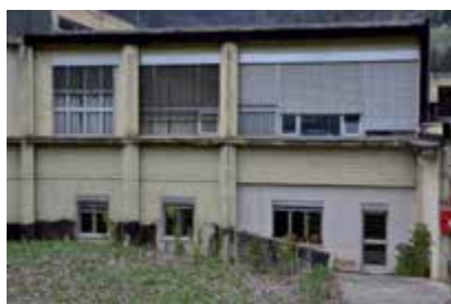
Fig. 4. Vista fronte nord della Scuola Media "L. Ghiberti"; zona uffici
