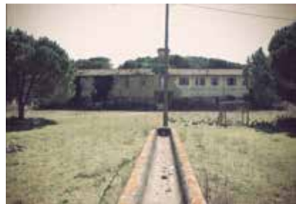
Fig. 8. Foto del manufatto allo stato di fatto: la palazzina, pozzo abbeveratoio
