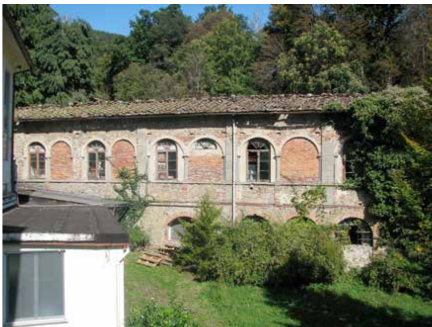
Fig. 2. Vista del porticato Settecentesco, volume a doppia altezza
