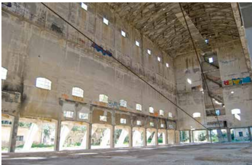
Fig. 2. Vista interna verso la scala di collegamento alle passerelle perimetrali. (novembre 2011)
