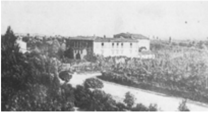
Fig. 3. Veduta dell'arena Bellotti-Bon dalla cinta muraria di Cascina
