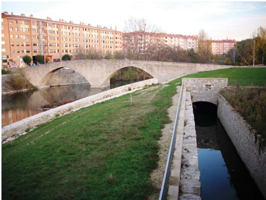
Fig. 2. Imagen del puente de Santa Engracia de Pamplona, en las inmediaciones del solar que albergó el convento de Clarisas, sobre el río Arga, y vista de las arcadas y cauce que discurrían hacia el molino medieval del Mazón (que salieron a la luz a finales de la primavera de 2013). © Anna K. Dulska
