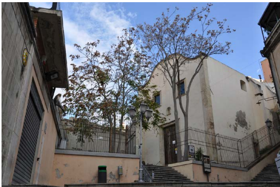
Fig. 1. Cagliari, chiesa di Santa Chiara (sec. XVII).
