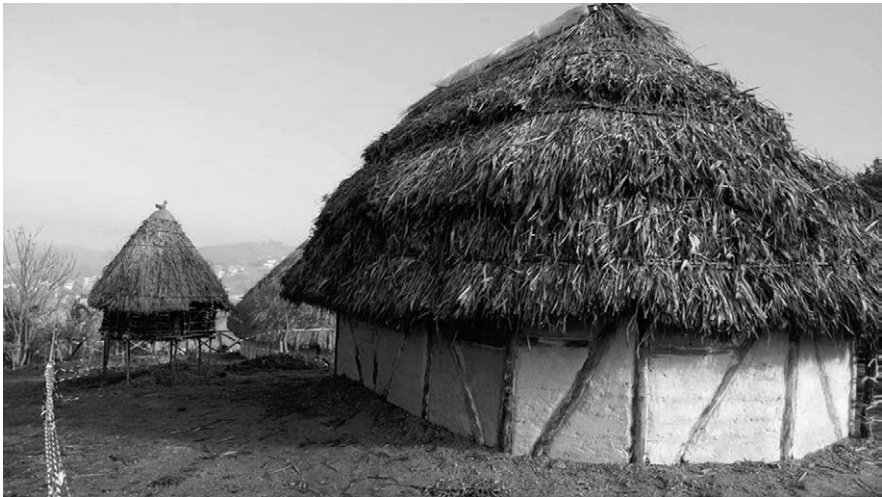
Figura 7 – Le nuove strutture in corso di conclusione.
