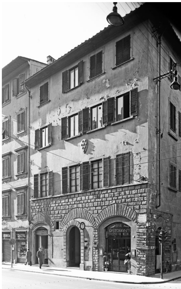
Fig. 59. Palazzo Vai; Firenze, via Cavour.
