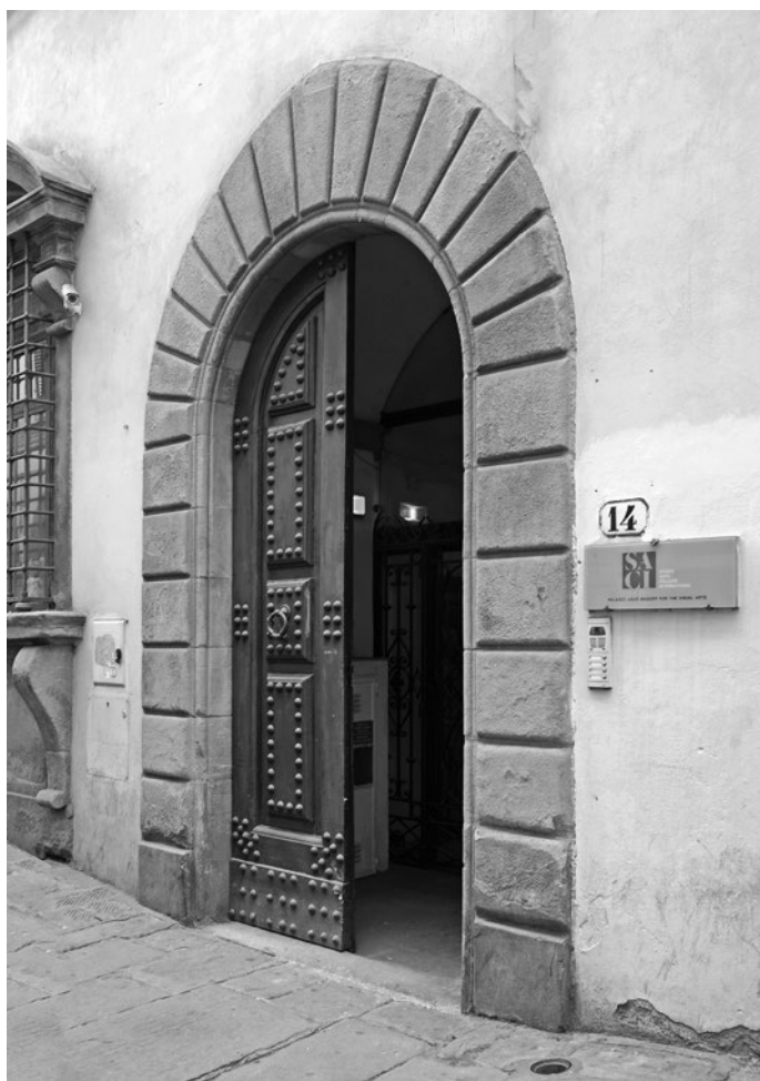
Fig. 117. Casa in via Sant'Egidio 14 (casa Panattoni), il portale; Firenze.
