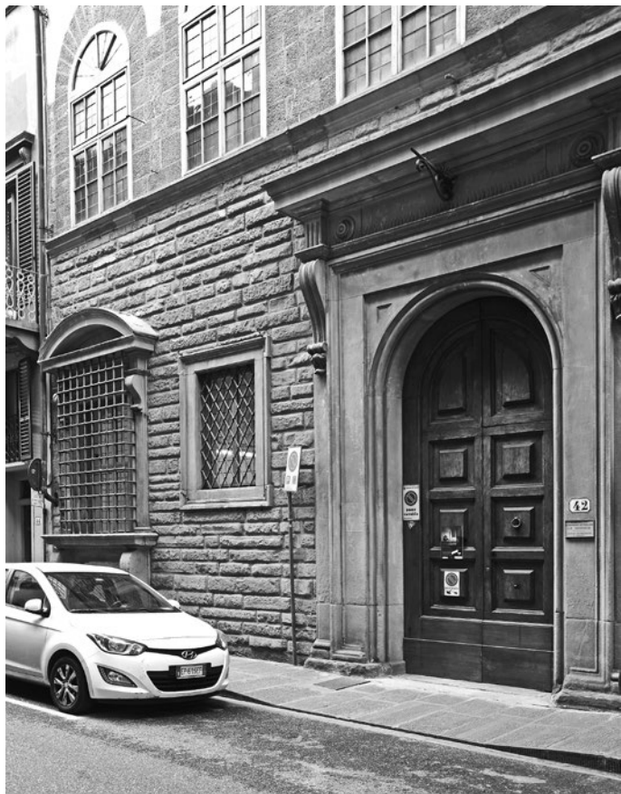
Fig. 84. Palazzo Corsini, dettaglio del basamento; Firenze, via Maggio.
