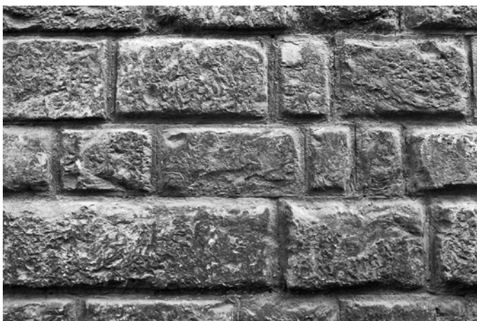
Fig. 37. Palazzo Corsini, dettaglio del paramento (bugne B); Firenze, via Maggio.
