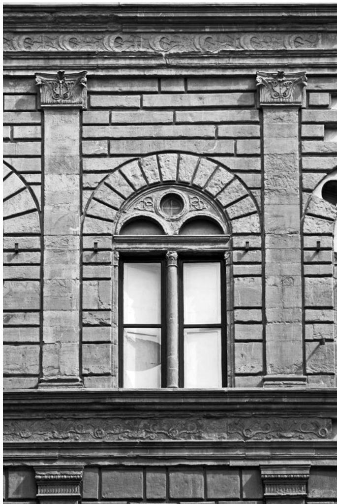
Fig. 99. Palazzo Rucellai, dettaglio del primo piano; Firenze, via della Vigna Nuova.
