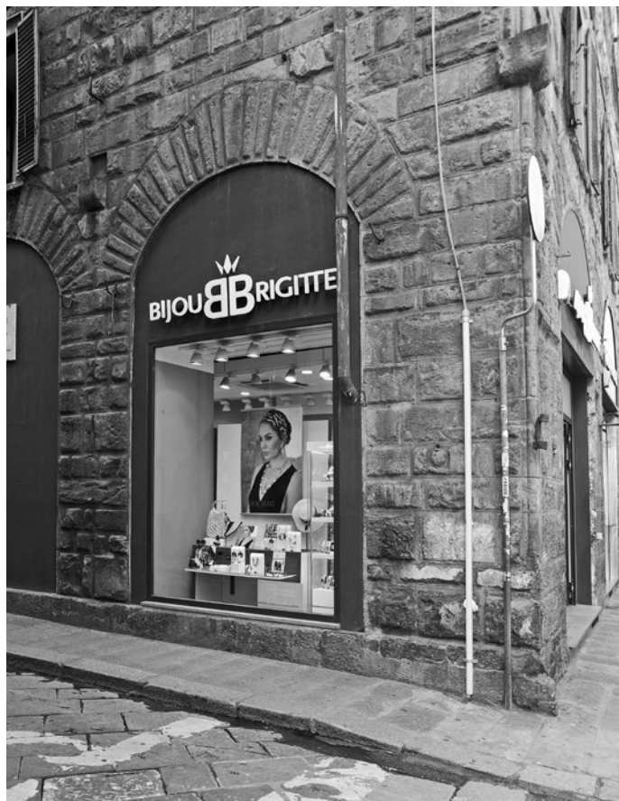
Fig. 71. Palazzo Bezzoli, dettaglio; Firenze, via de' Cerretani.
