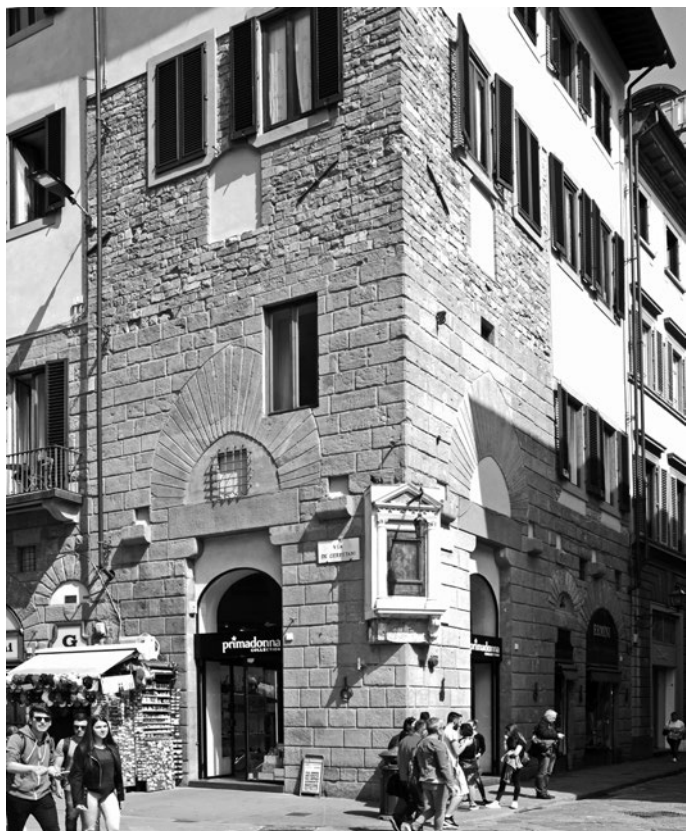
Fig. 57. Torre del Vescovo; Firenze, via de' Cerretani.
